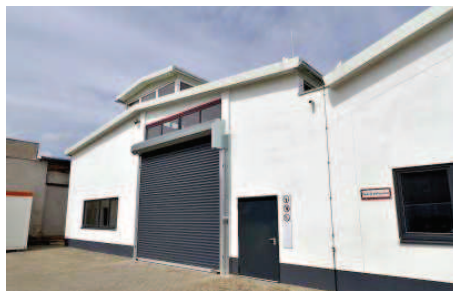
Die sanierte Halle von außen
